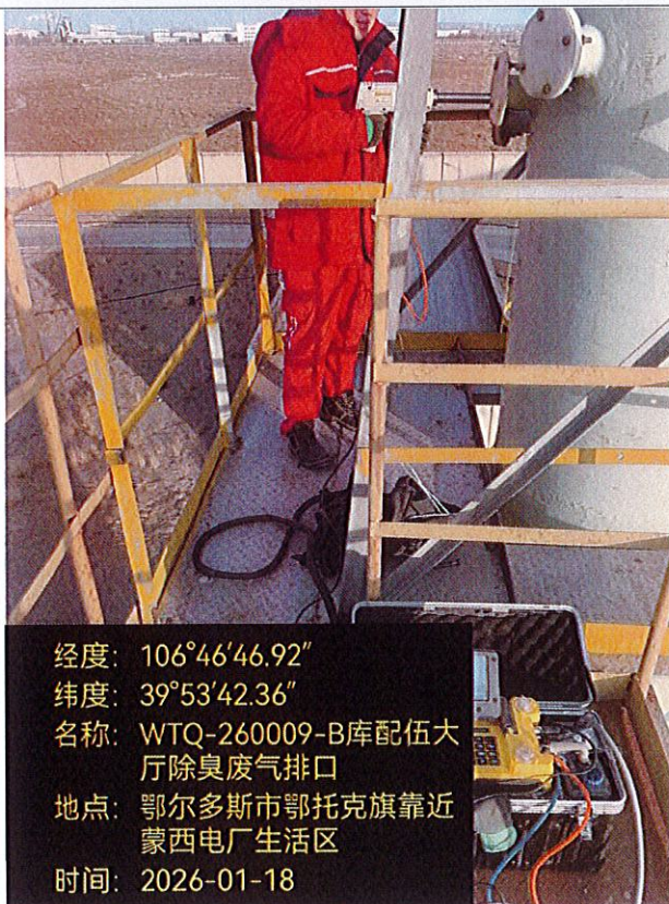
B 库配伍大厅除臭废气排放口 采样
